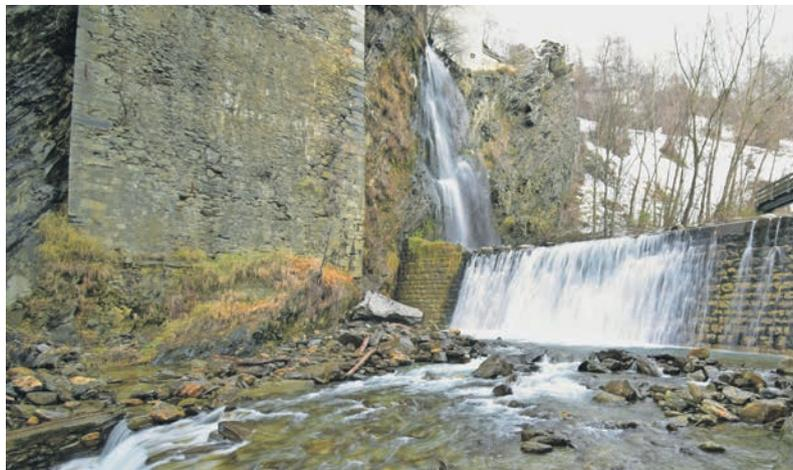
Soll mit einem Betonriegel verstärkt werden: die Napoleonsperre.
