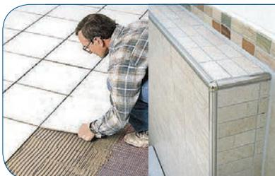
Während dem **5., 6. und 7. Tag** werden Wandschlitz und Unebenheiten in Ihrem Mauerwerk beseitigt und alle Flächen für das Fliesen vorbereitet. Die Dusche und Badewanne werden gestellt und angeschlossen. Danach wird der Fliesenleger diese ausmauern, sowie die Wände als auch den Boden verfliesen und ausfugen.
