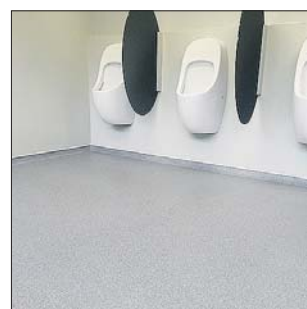
Boden- und Wandbeschichtung
