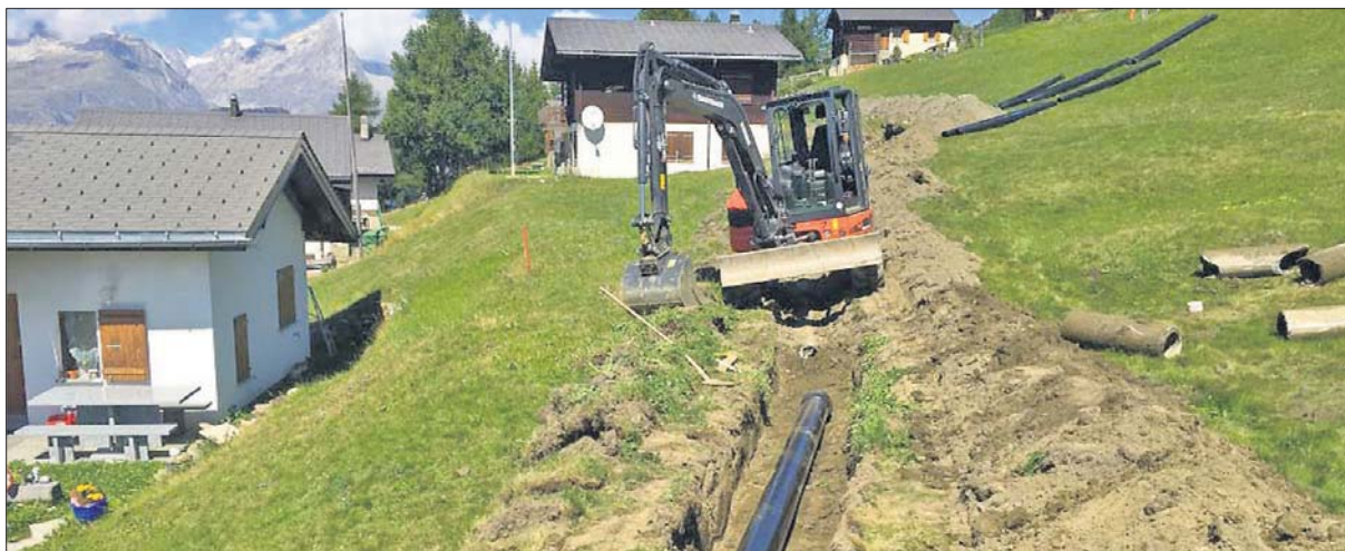
Vor Wintereinbruch konnte die Kanalisationsleitung auf dem Rosswald erneuert werden.
