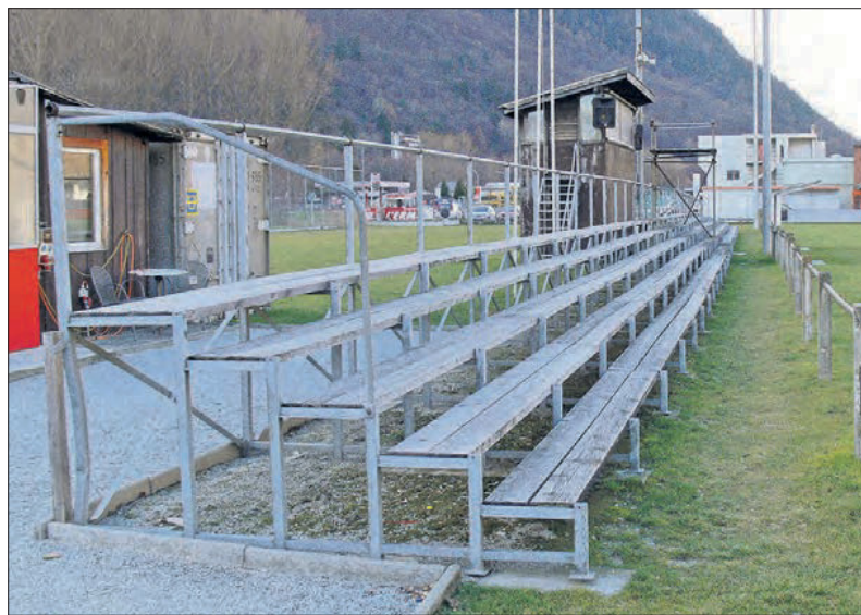
Sanierungsbedürftig: Die alten Tribünen auf dem Rhoneglut.
