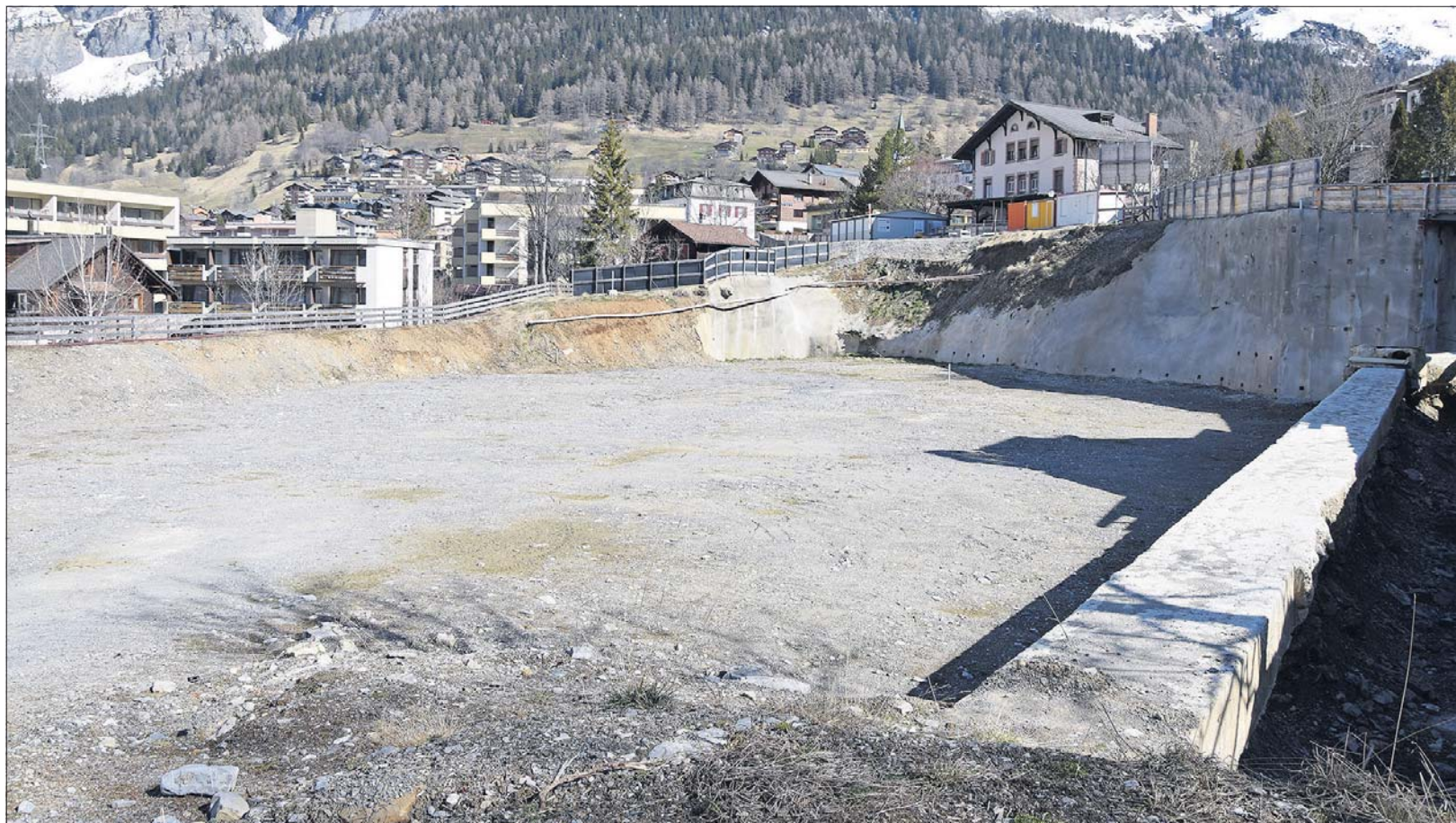
Verwaist: Auf der «51degrees»-Baustelle in Leukerbad wird nicht mehr gearbeitet. Die Baufirma wartet auf einen Teil des Geldes, der Bauherr schweigt und die Gemeinde reagiert gereizt.
