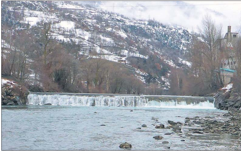
...und die hydrologische Messstation der Vispa.
