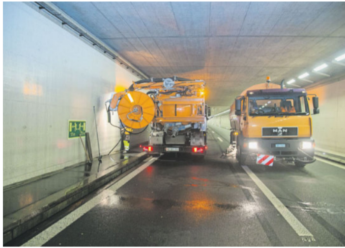
Tunnel der A9. In den kommenden Wochen finden Reinigungs- und Unterhaltsarbeiten statt.
